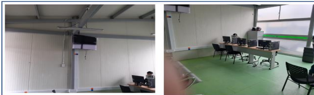
Imagen 10. Pisos y señalización zona de Servicio al Ciudadano.
