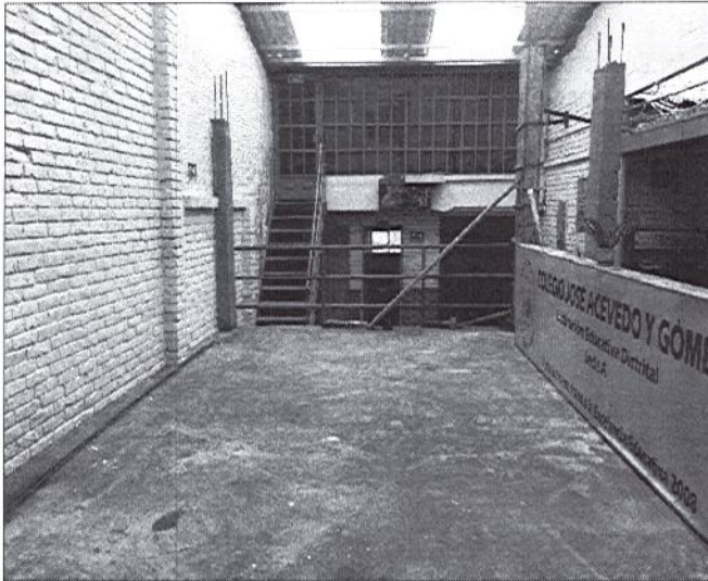
Fotografía de patio Sede A donde se levantaron columnas y placa.
