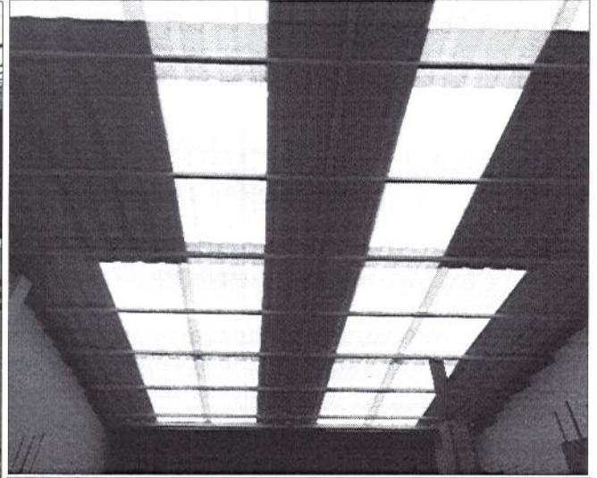
Fotografía tejado patio Sede A el cual fue reemplazado en su totalidad junto con la elevación de muros
