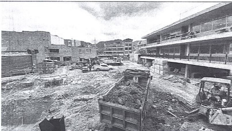
Imagen 1. Fotografía de las obras del Colegio Guillermo León Valencia que evidencia la continuidad de las actividades de obra durante el periodo de suspensión. Fuente: OCI Fecha 26/09/2019
