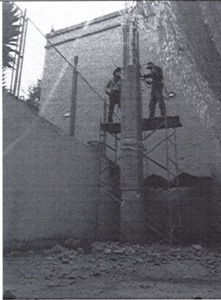
Demolición de columna existente para ampliación de cafetería
