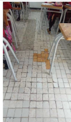
Estado de cancha y enchape antes de la intervención
