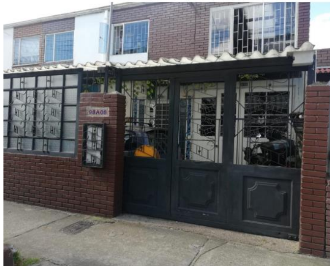
Fotografías, inmueble ubicado en la Calle 73 A No. 98 A-08 (Dirección con licencia)
