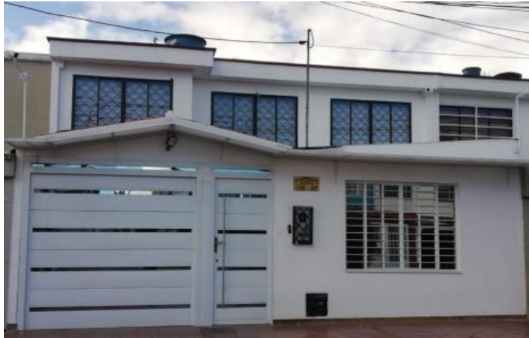
Fotografías, inmueble ubicado en la Calle 74 A No. 100-40.
