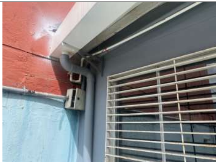
Fotografía 2. Nueva red de suministro de agua potable al interior del Col. Alfredo Iriarte (IED), sede B, El Mirador. Localidad de Rafael Uribe Uribe.
