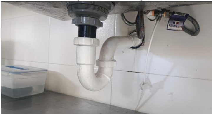
Imagen 6. Ducto con desagüe
