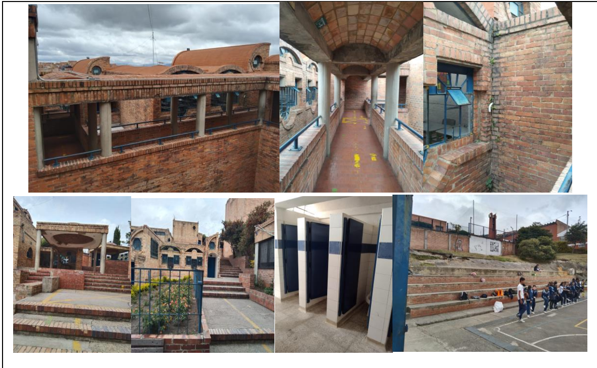
Ilustración 6 Registro fotográfico Visita 25 de mayo de 2026 Colegio Confederación Brisas Del Diamante (IED) Sede B
