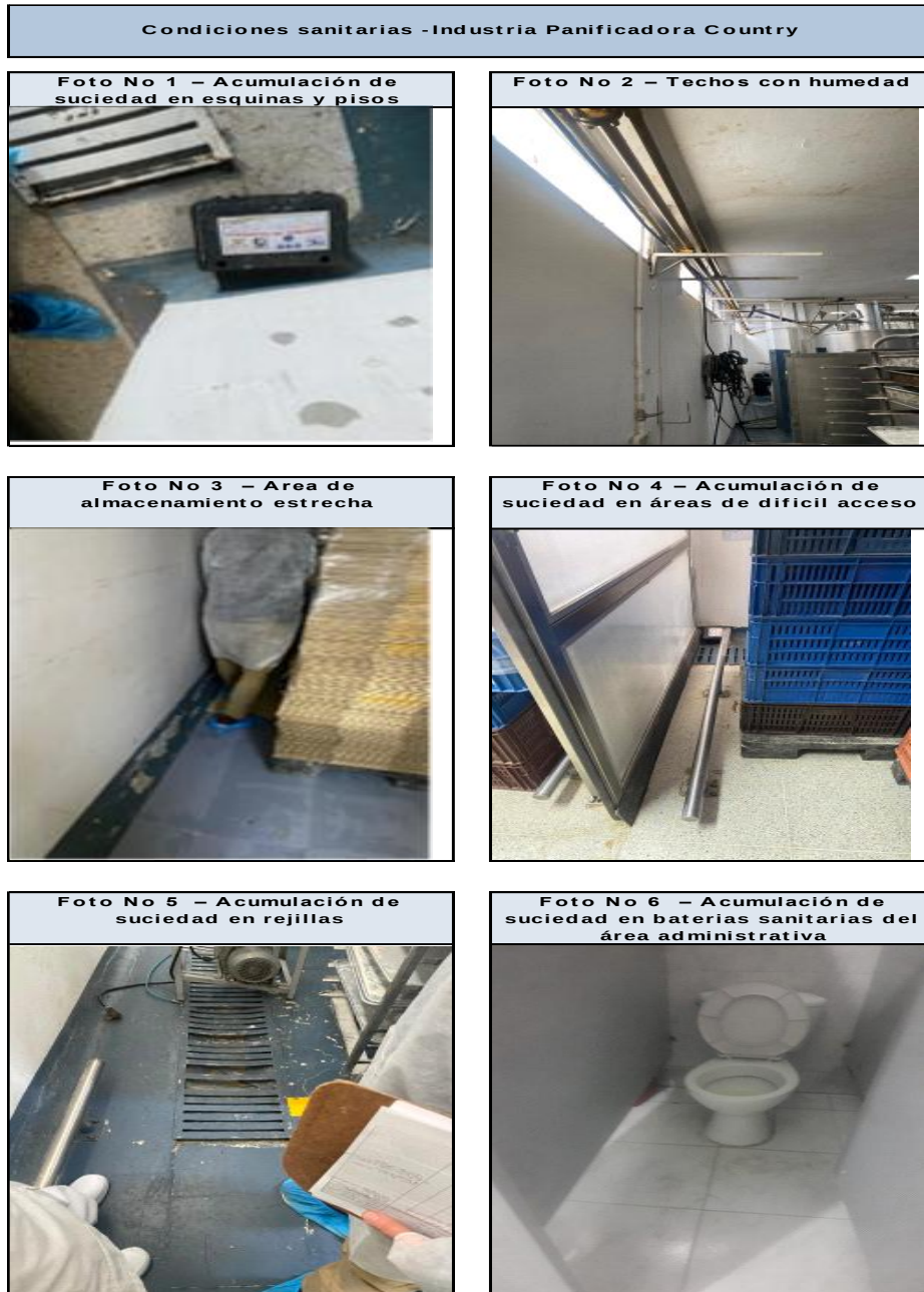
Imagen 2. Condiciones sanitarias Industria Panificadora Country
