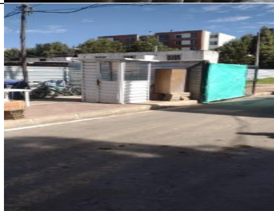
Instalación puesto de vigilancia con caseta nuevo Colegio Abel Rodriguez Cespedes – Engativá – diciembre 2022
