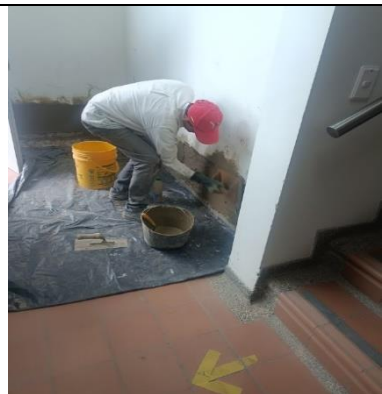
Foto No. 7 Verificación de obras de mantenimiento del archivo central
