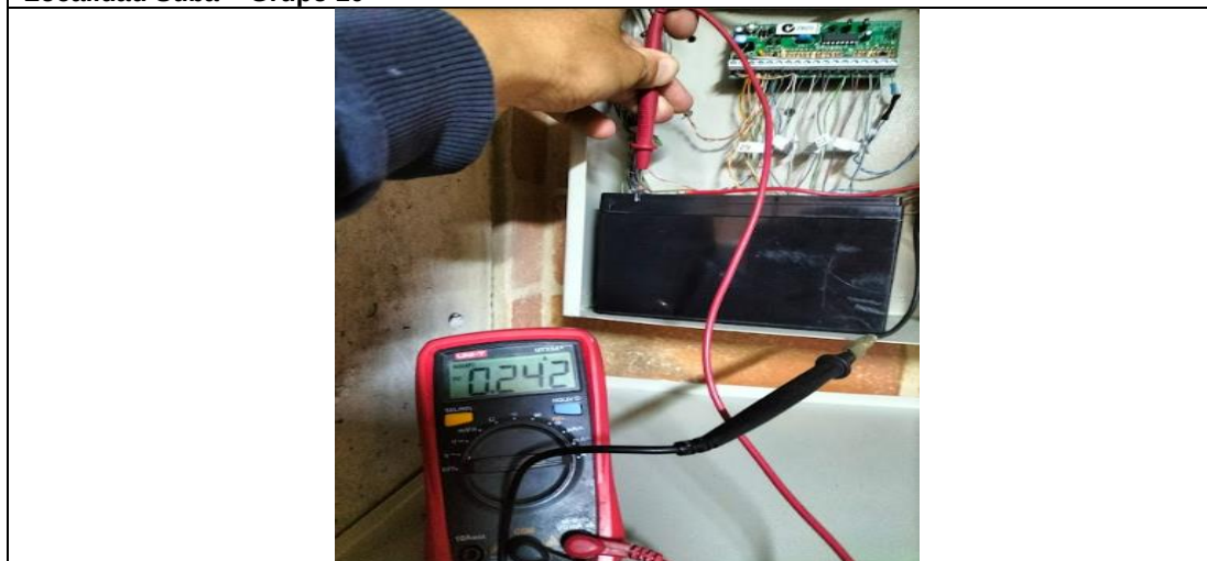
Foto No. 7 – Correctivo sistema de alarmas – Cambio Batería Panel – Colegio Villemar el Carmen sede A - Localidad Fontibón – Grupo 8
