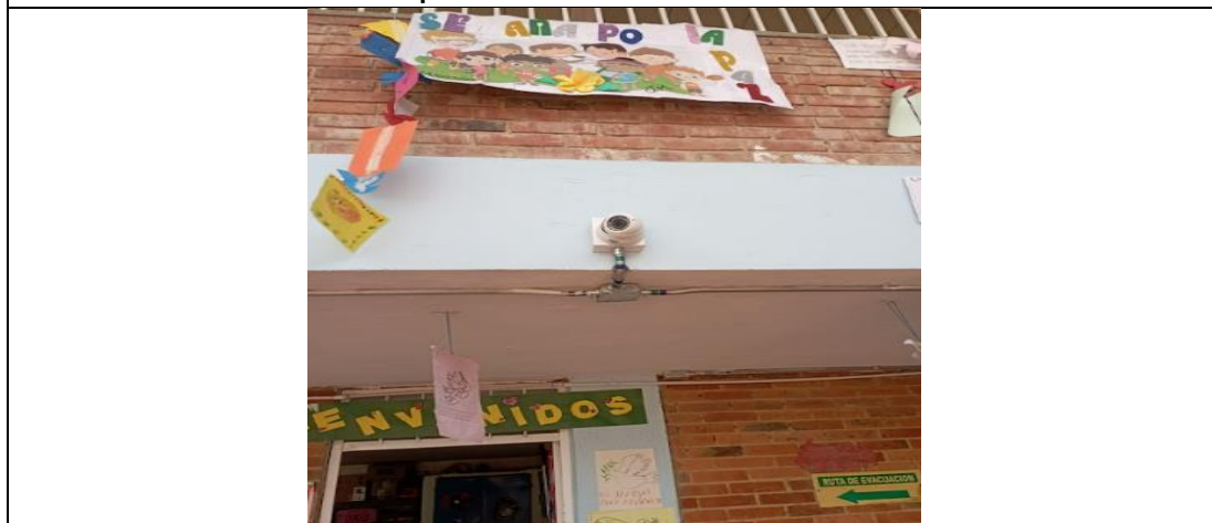
Foto No. 5 – Mantenimiento correctivo CCTV – Cambio de cámara – Colegio Diego Montaña Cuellar Sede C - Localidad Usme – Grupo 4
