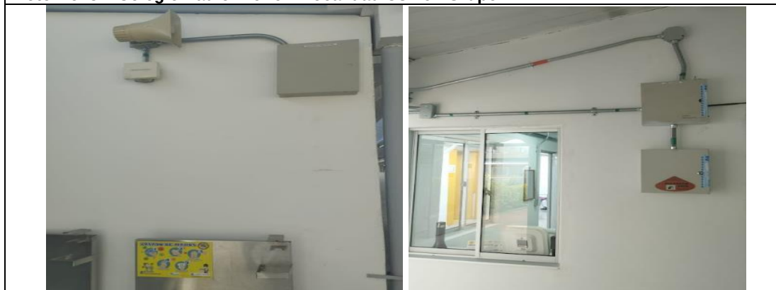
Foto No. 4 – Mantenimiento correctivo Alarmas – Reinstalación – Colegio El Jazmín – Localidad Puente Aranda – Grupo 8
